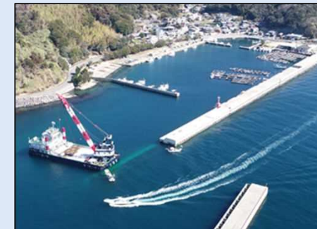
佐賀関漁港 防波堤耐震工事
