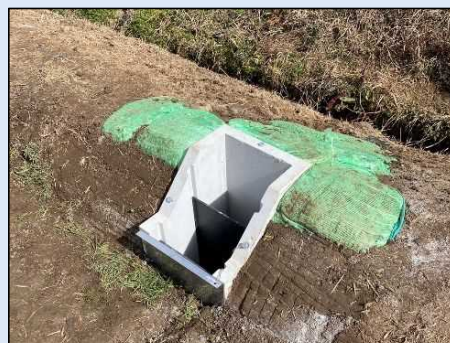
田んぼダム用排水柵の設置(由布市)
