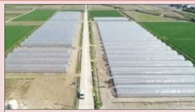
水田(2ha)に整備されたこねぎ用ハウス(池ノ内地区)
