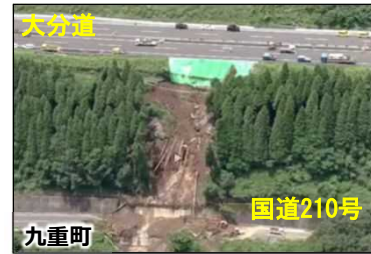
▲令和2年7月豪雨での被災状況
