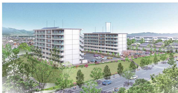
【A区画 南東側】
