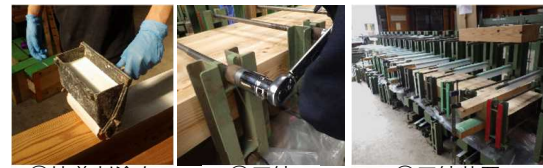
①接着剤塗布 ②圧縮 ③圧縮装置
