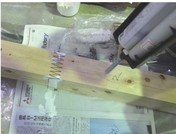
写真-2 GIR 用接着剤を充填している様子
