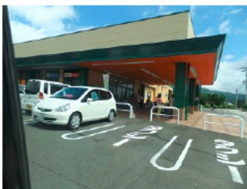
写真 6.2.5 大型商業施設等は乗継拠点として検討可能
