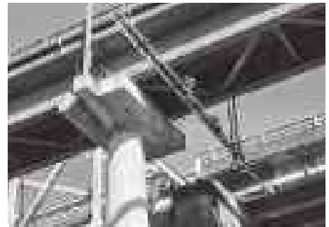
長寿命化計画に基づき橋梁点検の実施 (一般県道中判田犬飼線 犬飼橋側道橋：豊後大野市)
