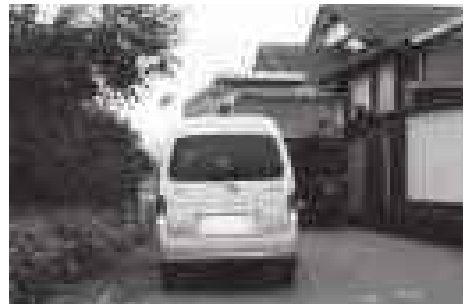
集落と幹線道路を結ぶ道路の幅員狭小箇所 (主要地方道日之影宇目線：佐伯市)
