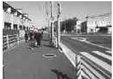
歩道の整備による通学児童の安全確保 一般県道万田四日市線（永添工区）
