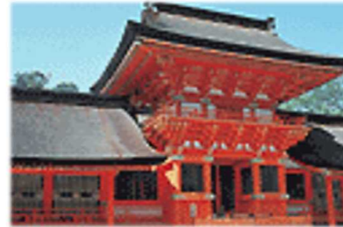
市町村指定有形文化財(建造物) 760件(令和4年5月1日現在)
