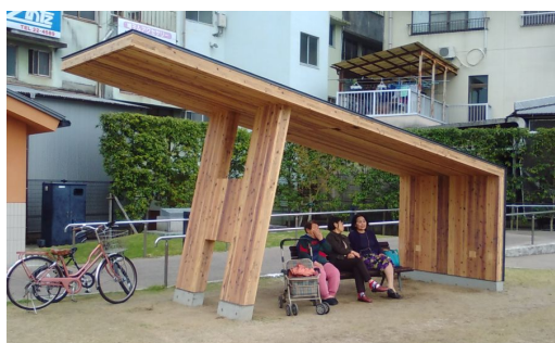
CLT東屋の設置(日田市)
