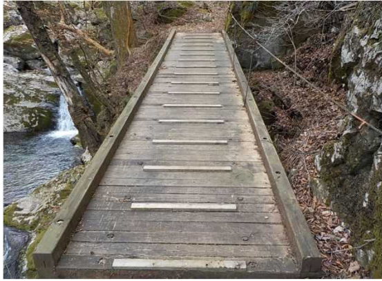
九州自然歩道木橋整備
