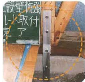
施工上ホールダウン金物を取付けるのが困難なところに代替として鋼板を加工したものを取付けた例(認定金物ではありません)
