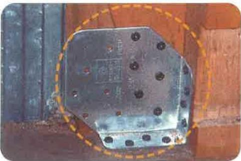
地震時に、揺れで部材が分解しないように、すじかいの両端を接合金物で固定します。
