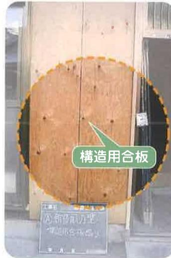
壁に厚さ7.5mm以上の構造用合板（強度の強い板材）を貼り、横揺れに強い壁に補強します。
