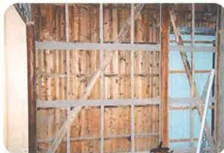
壁にすじかいを入れ、さらに構造用合板を貼り、横揺れに強い壁に補強します。
