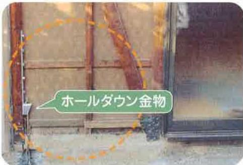
地震時に、すじかいや構造用合板などにより壁を強くした部分に対して、柱が土台から抜けようとする力が大きく働きます。
