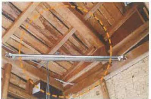
小屋組みや梁の部分を斜めに連結し、変形を抑えます。
