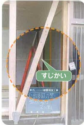
すじかい（斜めに設置した木材）により、横揺れに強い壁に補強します。各部材の接合部は専用の金物で補強します。
