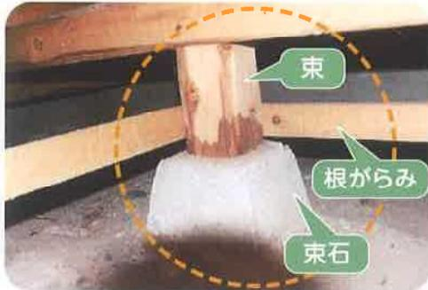
根がらみにより床下の束(床を支えている部材)が動かないように連結します。
