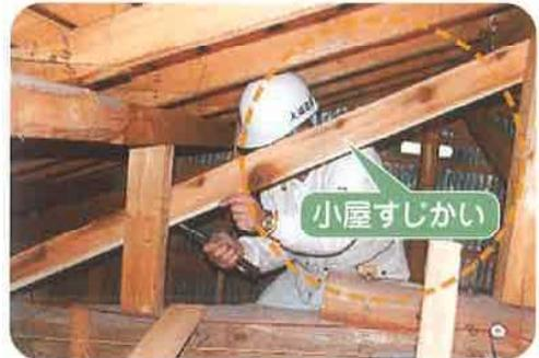
小屋すじかいにより小屋組みの部材が動かないように連結します。
