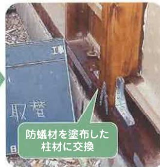
防蟻材を塗布した柱材に交換
