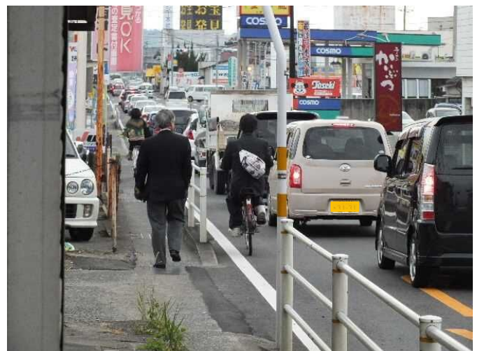
まちなかの幹線道路で交通量が多く歩道整備が不十分
