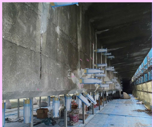
ひび割れ注入状況（中村鬼瀬停車場線：篠原橋）
