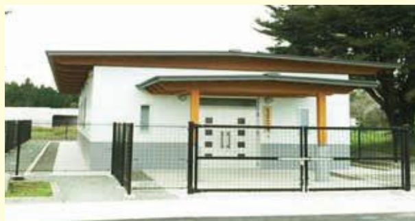
豚凍結精液研究棟（受託精液凍結施設）
