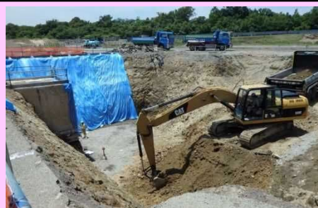
H29 進捗状況 (地下通路周辺)
