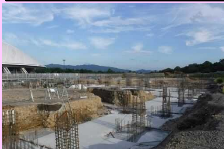
H29 進捗状況 (基礎・ピット柱)
