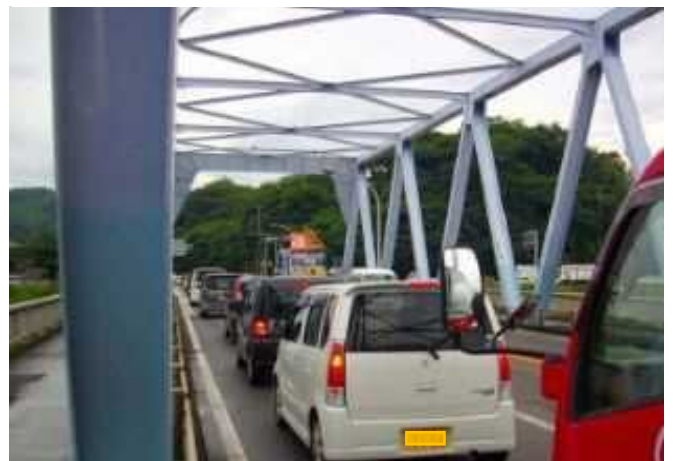
まちなかの幹線道路で交通量が多く歩道整備が不十分
