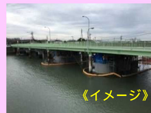
橋梁耐震化工事
