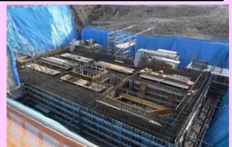
H29 進捗状況 (地下1階部分)
