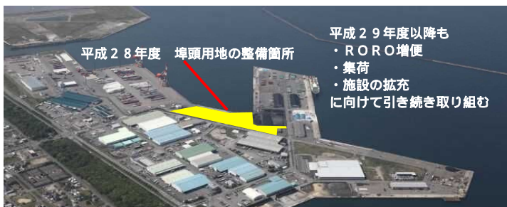
大分港(大在地区) 平成28年度 埠頭用地の整備
