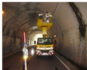
トンネル点検状況 県道佐伯蒲江線（佐伯市）
