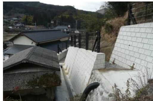
急傾斜地崩壊対策事業 雲谷寺地区（中津市）
