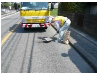
異常箇所の早期発見・補修
