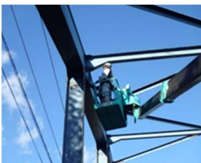
橋梁の点検状況 県道別府庄内線（由布市）
