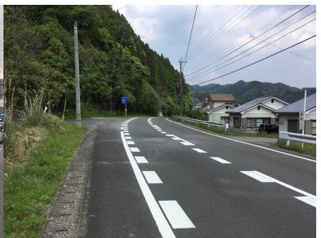
一般県道 赤木吹原佐伯線 ドットラインの設置
