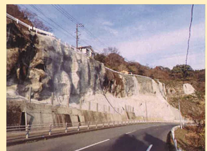
国道442号野津原工区（大分市）
