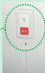
和式便器を洋式便器に交換して段差をなくし、手すり、非常呼び出しボタンを設置します。
