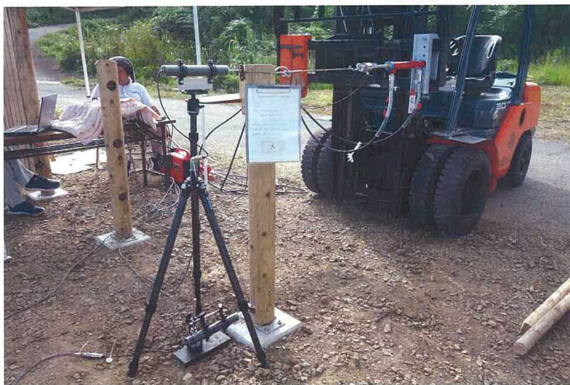
図 2. 9 境界フェンス用支柱の水平荷重試験の様子
