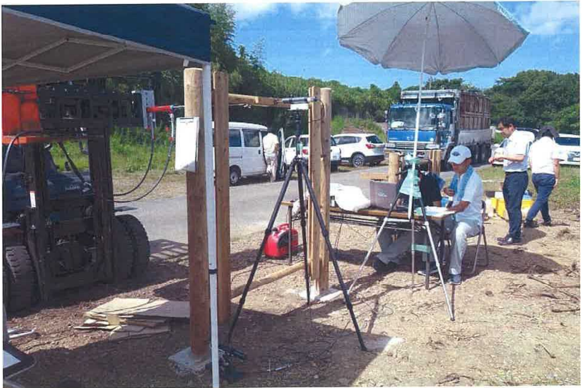
図 2. 5 目隠しフェンスの水平荷重試験の様子
