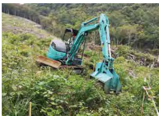
重機等を用いた下刈りの機械化
