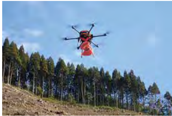
ドローンを活用した資材運搬
