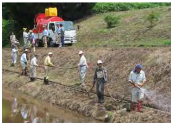
センチピードグラスの種子吹き付け作業
