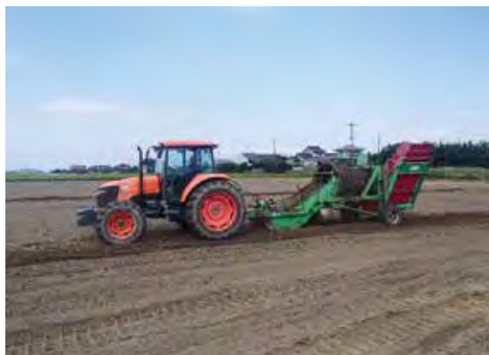
機械施工による土壌改良（除レキ）
