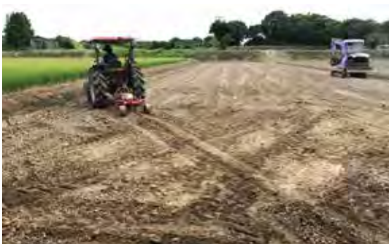
弾丸暗渠による排水対策
