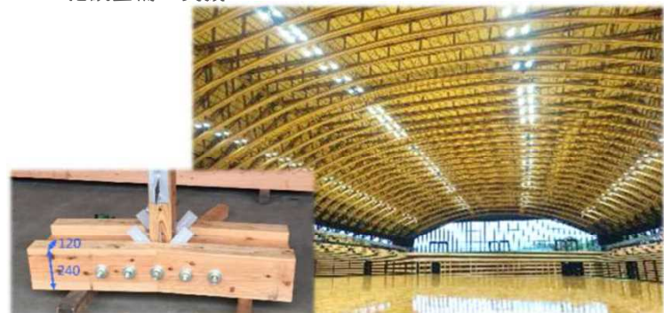
スギ無垢乾燥材の利用による木造建築の推進 (昭和電工武道スポーツセンター)
