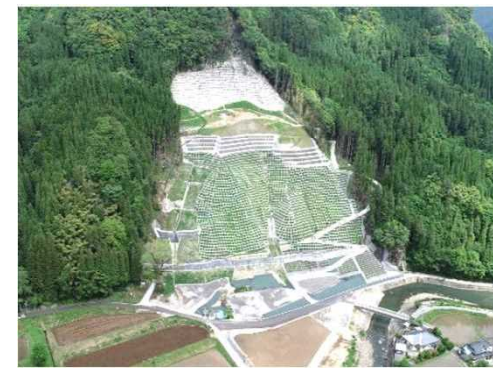
災害復旧工事
