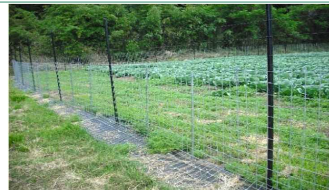
畑に設置された防護柵
