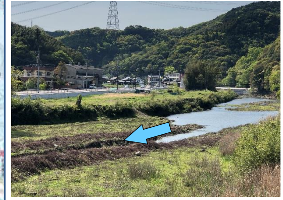
臼杵川(今後整備区間)
