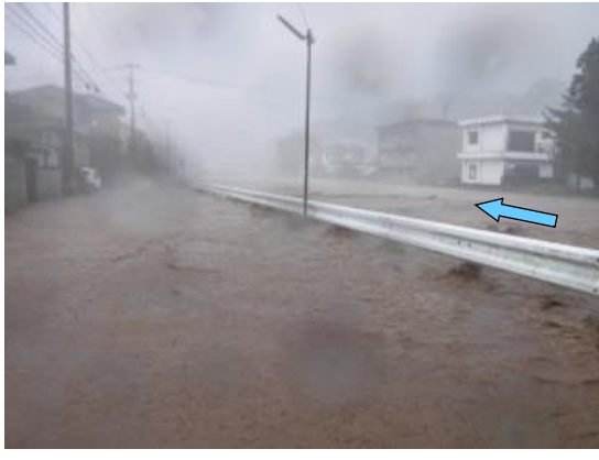
津久見川浸水写真(H29年9月)
