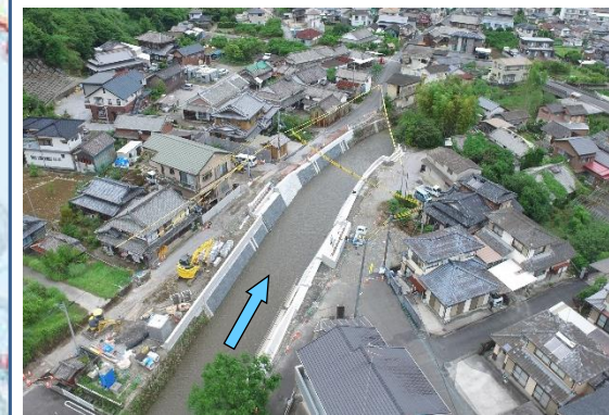
彦の内川(整備中写真)
