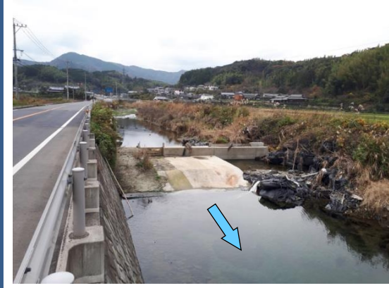
熊崎川(整備中写真)
