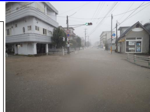
平成29年9月17日台風18号による内水被害
