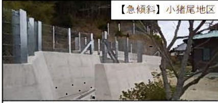
令和4年度の取組 急傾斜施設の整備
