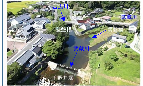
武蔵川(整備中状況写真)
