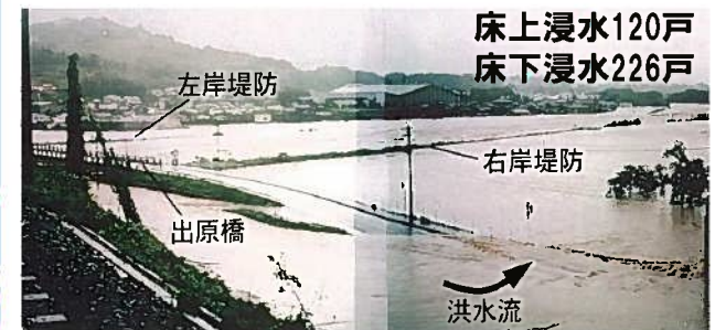
八坂川浸水写真(H9年9月)
