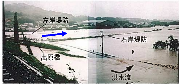
八坂川浸水写真(H9年9月)
